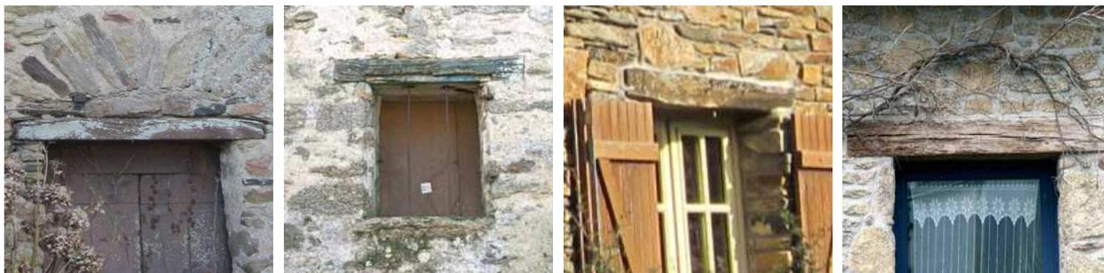
Sur le bâti le plus ancien, les pierres d'encadrement et le linteau en bois possèdent la même «feuilleure» permettant l'encastrement du volet se fondent dans un parfait mimétisme. Les linteaux en chêne naturel s'insèrent parfaitement au-dessus de portes et fenêtres de maisons restaurées.
