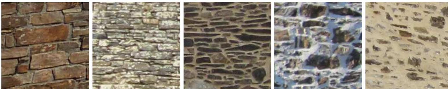
Exemples de maçonnerie en moellons observés sur Le Cellier.
