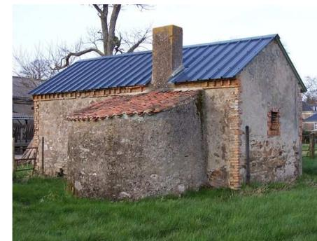
Four à pain – Exemple de rénovation de toiture non adaptée
