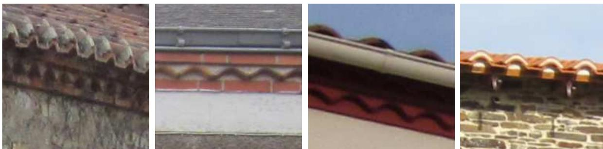
Beaucoup de corniches sont constituées d'un simple débord de pierre dure, sans moulures. Elles constituent une des caractéristiques de la commune. Sur les constructions des XIXe et XXe siècles, on rencontre des corniches en briques (qu'il ne faut pas confondre avec les génoises en tuiles et briques).
